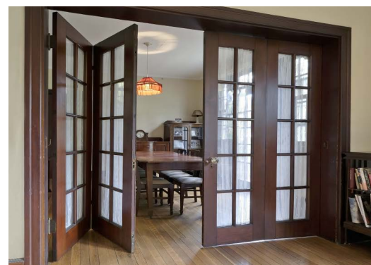
食堂と居間の間にある折戸式になった間仕切り。居間と一体的に使用することも、独立して使うこともできる
