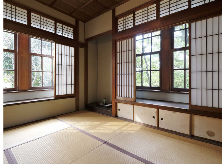
駒井家にある唯一の和室。窓は2カ所とも出窓になっていて、内側に障子を入れ、外からは完全に洋館に見えるように納めてある。中央の畳をはずすと冬は掘りごたつになる
