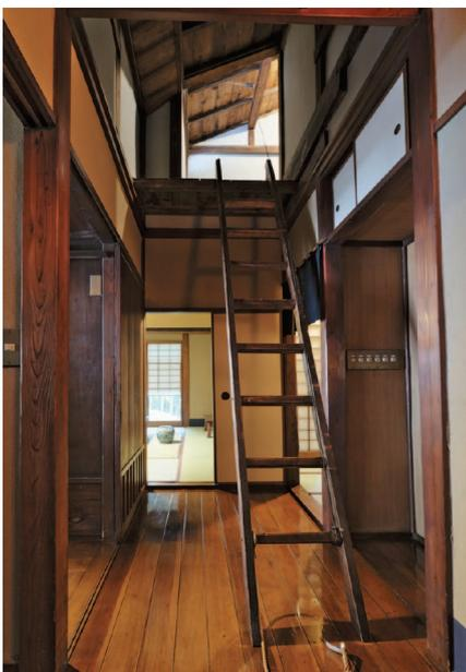
写真上は越屋根（こしやね）で、採光や煙出し用に屋根の上に小屋根をのせた構造。中は屋根裏部屋で天井裏に収納された梯子を下ろして昇降した（非公開）
