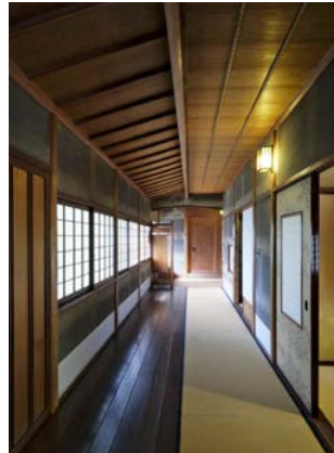
掛込（かけこみ）天井に畳と赤松の板張り床という片身替わりの廊下
