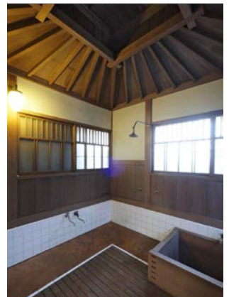
垂木が放射状に広がる唐傘天井の浴室。シャワー設備も整っていた
