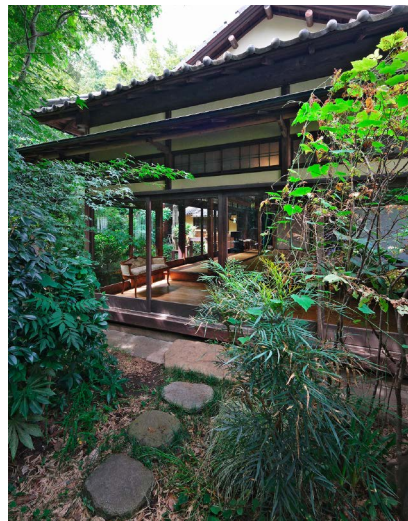
和館は、入母屋造りの棧瓦葺き。広縁から奥のサンルームまで、すべて中棧のない一枚の大きな硝子戸が使われている。桜の花模様の照明は建築当時のままである
