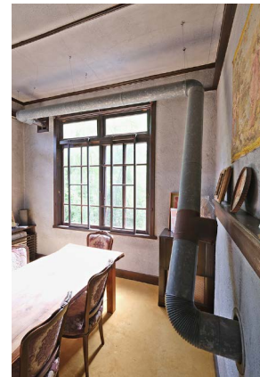
隣の寝室に伸びた暖炉の煙突。廃熱を利用して部屋を暖めた
