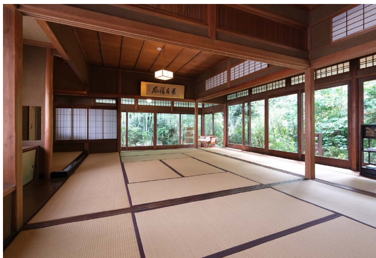
和館は、入母屋造りの棧瓦葺き。広縁から奥のサンルームまで、すべて中棧のない一枚の大きな硝子戸が使われている。桜の花模様の照明は建築当時のままである
