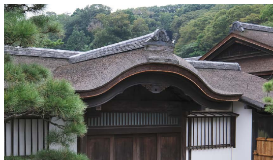
三溪園・臨春閣の玄関棟。修復工事を終えて、唐破風屋根の檜皮が新しく葺き替えられた
