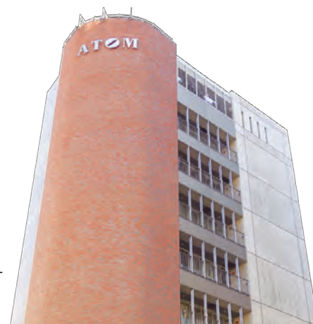
アトムCSタワー
