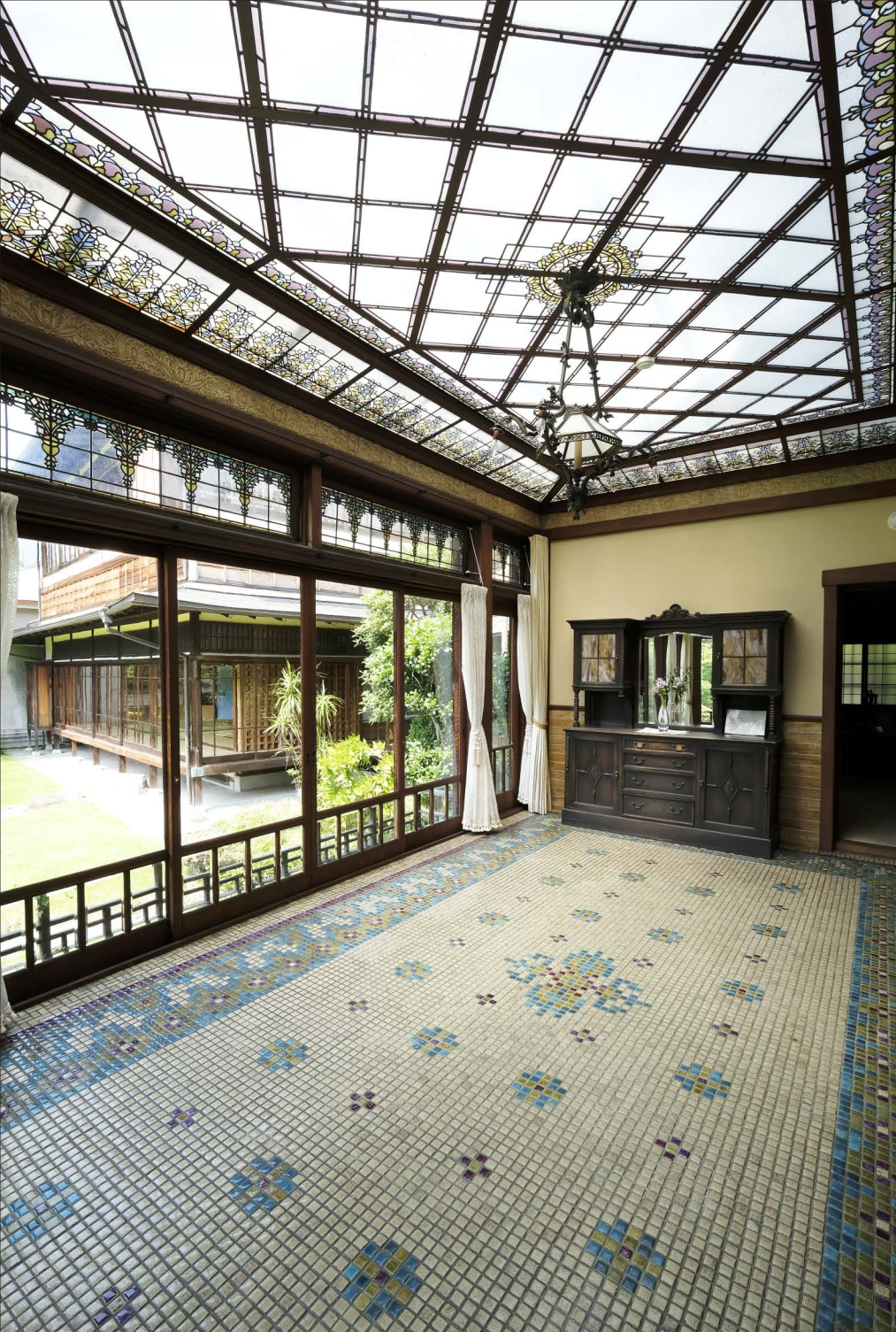
「玉姫」に併設されたサンルーム。陽光をたっぷり取り入れるために天井も屋根もガラスで葺かれ、鉄骨で支えている。天井と高窓の間には、唐草模様が刻まれた石膏の装飾がある
