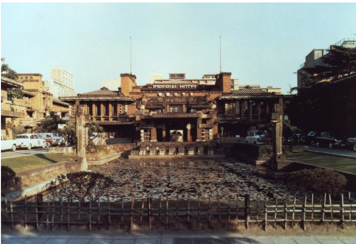
1923年（大正12年）8月、着工以来4年の歳月を経て竣工した「ライト館」。正面には蓮池があり、左右に広がる両翼が客室棟であった
