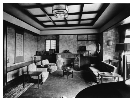
昭和11年の写真。居間兼客間には書院造に暖炉があった
