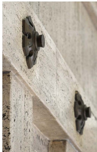
大理石の長押部分に釘はないが、釘隠しがデザインされている
