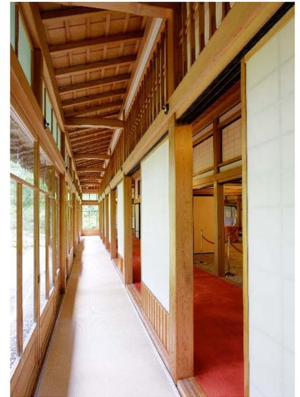
開放感を持たせるため窓側に傾斜している廊下
